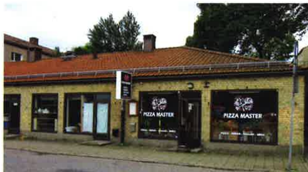
Centrumbyggnad vid Stortoppsgatan:s södra sida.
